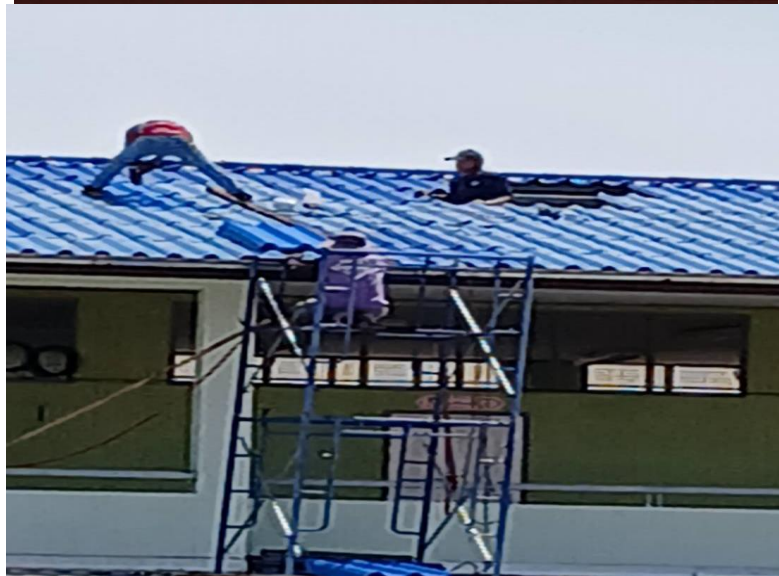
ซ่อมหลังคา อาคารรุ่งละหาน
