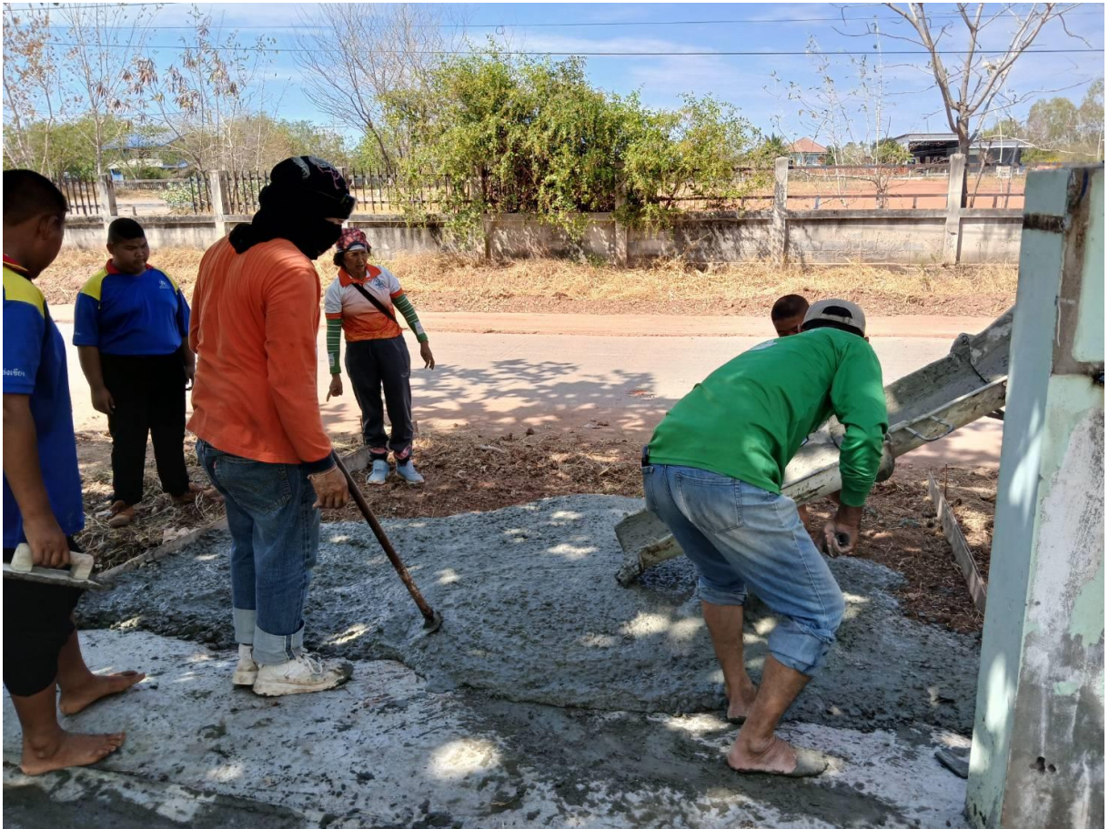
ทำประตูข้างโรงเรียนและถนนคอนกรีตทางเข้า
