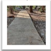
ทำทางเชื่อมห้องน้ำ – อาคารเรียน
