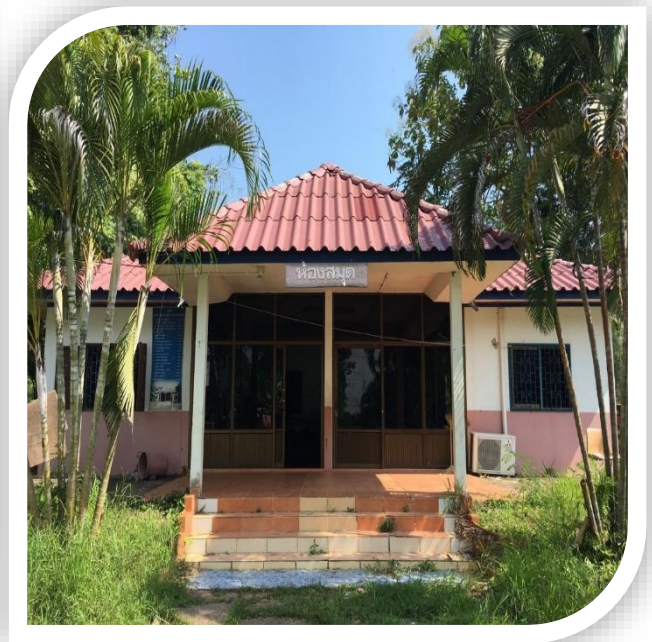
หอสมุด ปีที่สร้าง ๒๕๕๒
