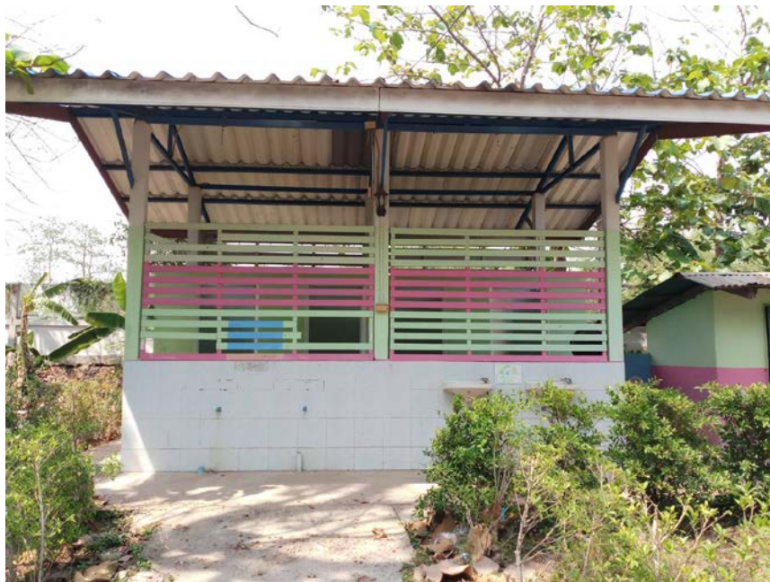
อาคาร สพฐ. 4(ส่วน 4 ที่นั่ง) ปีที่สร้าง 2555
