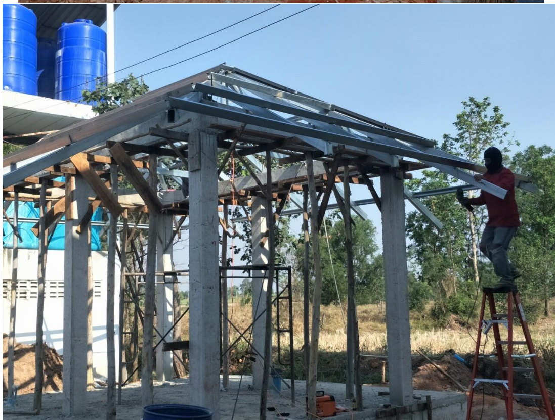
๒. โรงเรียนได้รับจัดสรร ส้วม ๔ ที่นั่ง งบประมาณ ๕๔๐,๐๐๐ บาท (ปีงบประมาณ ๒๕๖๖) จาก สพฐ. ผู้รับเหมากำลังดำเนินการก่อสร้างกำหนดในสัญญาแล้วเสร็จ ส่งมอบงาน ภายใน ๒ พฤษภาคม ๒๕๖๖
