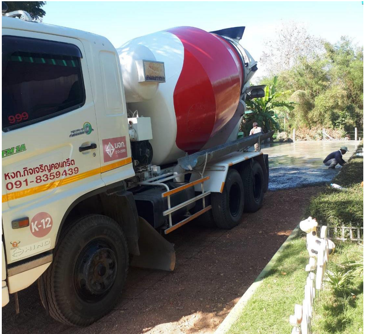
ภาพ การก่อสร้างถนนในโรงเรียน
