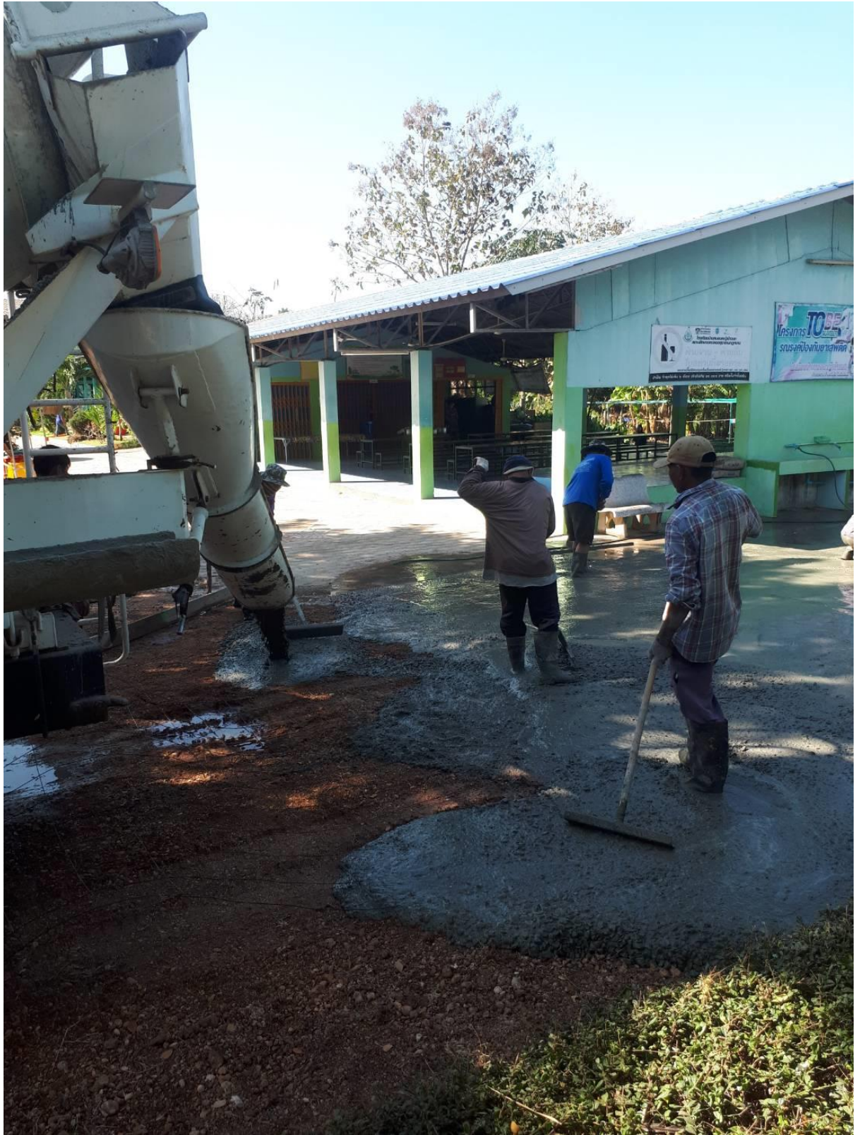
ภาพ การก่อสร้างถนนในโรงเรียน
