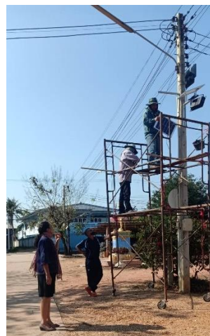
ติดตั้งไฟโซลาร์เซลล์
