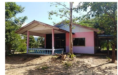
หอสมุด ปีที่สร้าง 2548 (ไม่ใช้งบประมาณจากทางราชการ)
