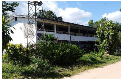
อาคารเรียน สปช.105/26 ปีที่สร้าง 2537
