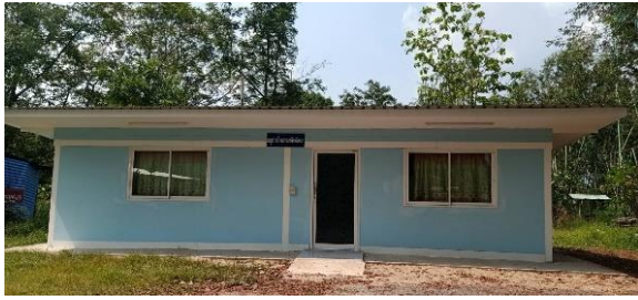
อาคารพยาบาล สร้างเมื่อ พ.ศ.๒๕๖๓ ปรับปรุงซ่อมแซม พ.ศ.๒๕๖๕ (ชาวบ้านบริจาคนำเงินมาปรับปรุงซ่อมแซมจาก สพฐ.)
