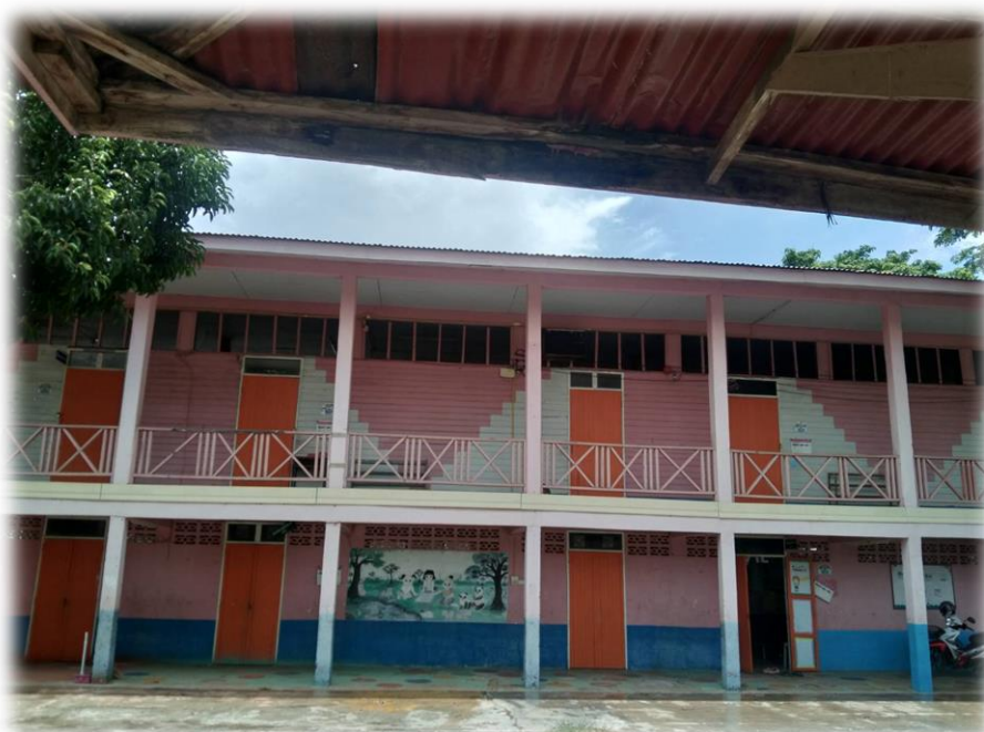
อาคารเรียน ป.๑น อาคาร(คสล.) ๒ ชั้น
