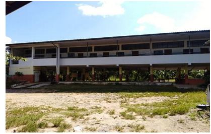
อาคารเรียน สปช.105/29 ปีที่สร้าง 2544
