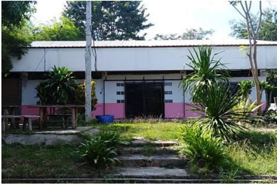
อาคารอเนกประสงค์ สปช.202/26 ปีที่สร้าง 2529
