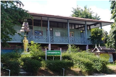
อาคารเรียน ป.1ฉ ปีที่สร้าง 2521
