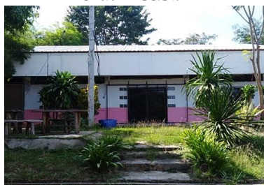
อาคารอเนกประสงค์ สปข.๒๐๒/๒๖ ปีที่สร้าง ๒๕๒๙
