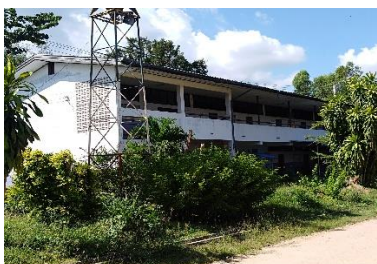
อาคารเรียน สปข.๑๐๕/๒๖ ปีที่สร้าง ๒๕๓๗
