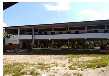
อาคารเรียน สปข.๑๐๕/๒๔ ปีที่สร้าง ๒๕๔๔
