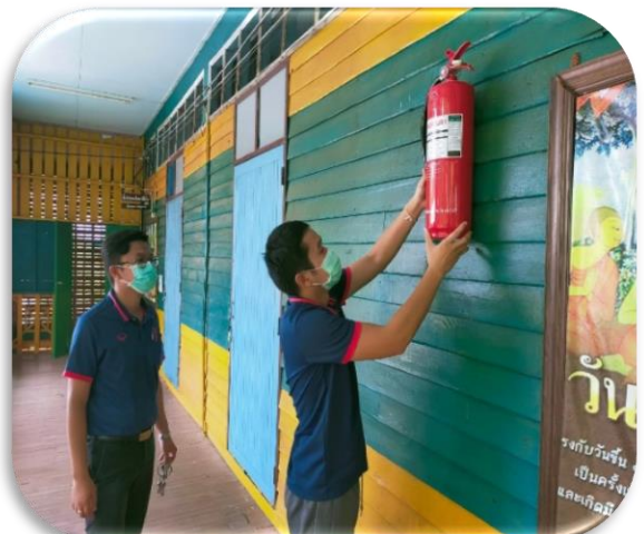
ภาพการติดตั้งถังดับเพลิงตามอาคารต่าง ๆ
