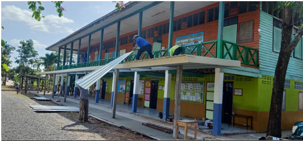
ภาพการปรับปรุงซ่อมแซมหลังคาอาคารเรียน
