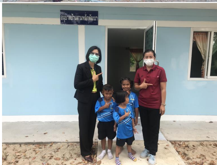
อาคารเรียนอนุบาลเสร็จสมบูรณ์
